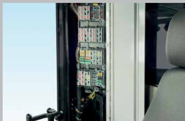
Skrzynka bezpieczników po lewej stronie kabiny.
